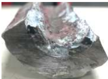
▷ boiler tube 내벽에 형성된 스케일
